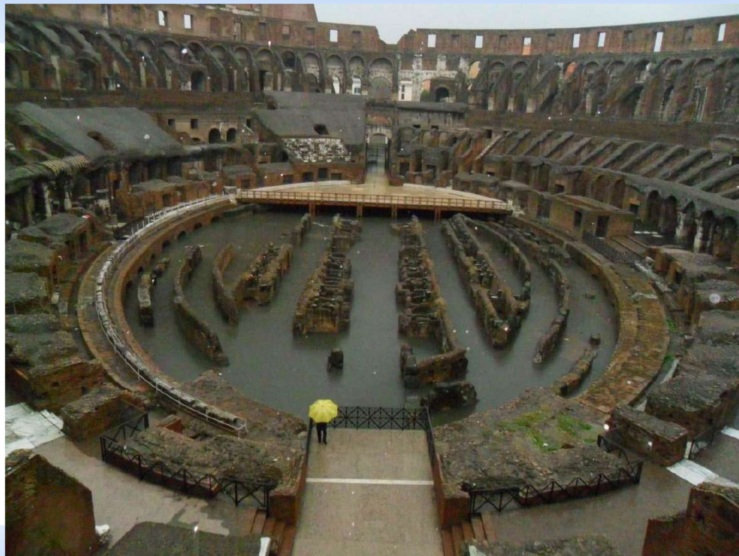
Allagamento degli ipogei del colosseo durante il nubifragio del 20 Ottobre 2011
